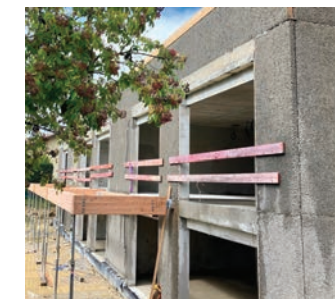
murs en béton de bois composé à 80% de copeaux de bois
