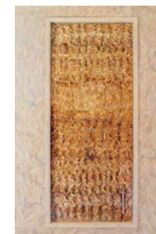
Bâtiment en ossature bois provenant de forêts alentours isolé avec des bottes de pailles haute densité
